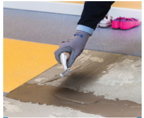
Regularizando una parte de la superficie
