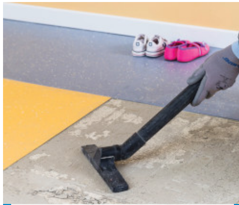
Eliminando el polvo con una aspiradora
