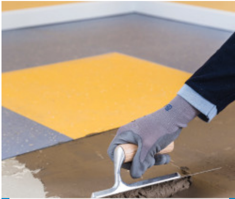
Regularizando la superficie a ras del sustrato
