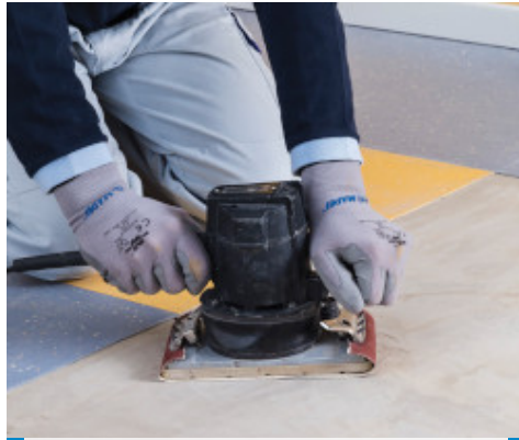
Lijando la superficie después de 2 horas
